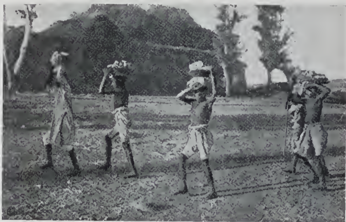
Abb. 10. Herbeischaffen der Bausteine.
